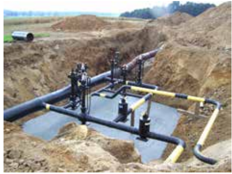
Abb. 5: Baugrube der Gasverteilerstation 600 m nordöstlich von Wiesa, Blick nach NW Richtung Wiesa. Foto: Th. Giesler im Juli 2008
