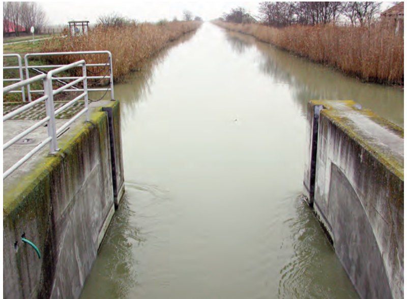
Abb. 7: Einserkanal mit Schleuse, Blick Richtung W.
