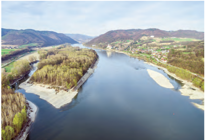
Abb. 16: Permanent durchströmter Nebenarm und Kiesstrukturen an der Donau bei Schallemmersdorf – Schönbühel. Aufnahme bei Niederwasser. Foto: Haslinger.
