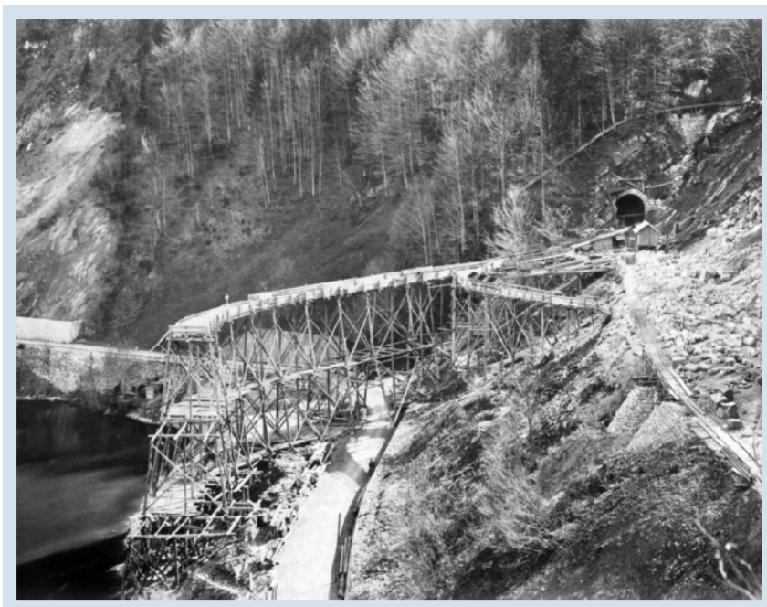
Abb. 2: Bauarbeiten am Nordportal des Sonnstuntunnels zwischen Ebensee und Traunkirchen, 1877.
