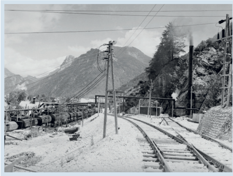
Abb. 7: Teil des Steinbruchgeländes mit der in die Stollenanlagen verlegten Erdölraffinerie, 1944. Links Kesselwaggons mit dem angelieferten Rohöl, rechts die Energiezentrale für die Anlage (ebenfalls in einem eigenen Stollen untergebracht).
