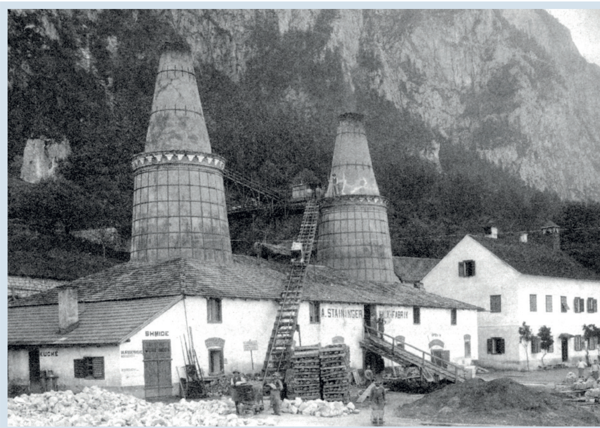
Abb. 4: Kalkbrennöfen der Staininger-Kalk-Fabrik „Unterm Stein“ bei Gmunden, die bis 1968 unter dem Namen „Kalkwerke Gmunden“ betrieben wurden.
