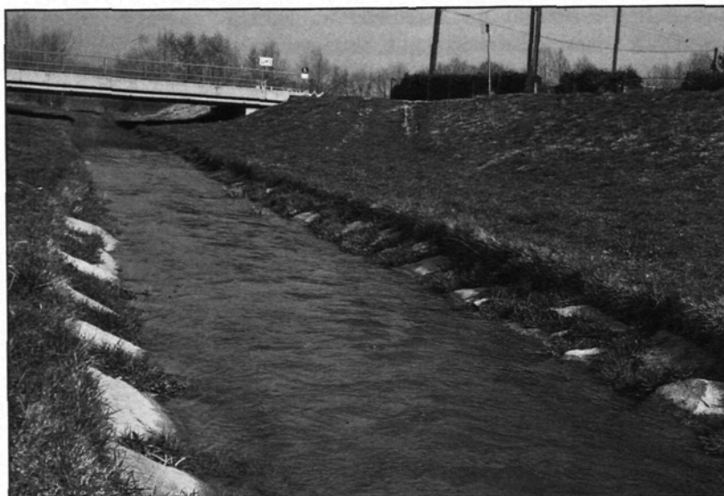
Abb. 3: Regulierter Wambach-Unterlauf mit typischem Trapezprofil und Uferwiesen.
