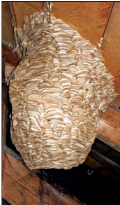
Dachboden-Nest von außen.
