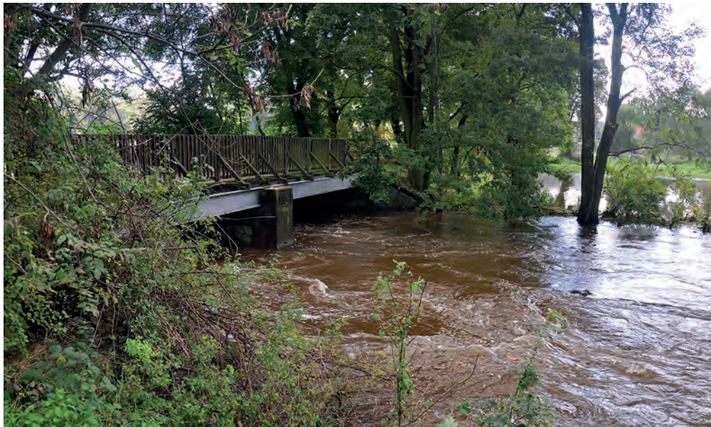
Abb. 13: Der Röderkanal an der Skassaer Brücke (U1) bei Hochwasser.
