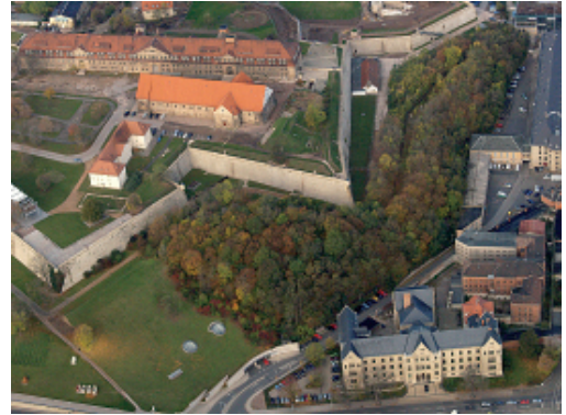
Abb. 4: Luftbild-Schrägaufnahme vom Osthang des Petersberges mit dem größeren Feldgehölz als Teilgebiet des GLB. Oben links ist die romanische Peterskirche zu erkennen, deren Zwillingstürme und das originale Dach nicht mehr vorhanden sind. Foto: D. Stremke, LaNaServ, 2006
