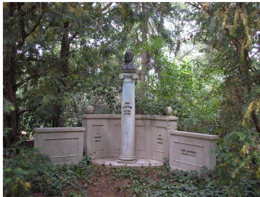
Abb. 4: Grabmal nach der Instandsetzung im Sommer 2011 (Foto: M.-S. ROHNER).
