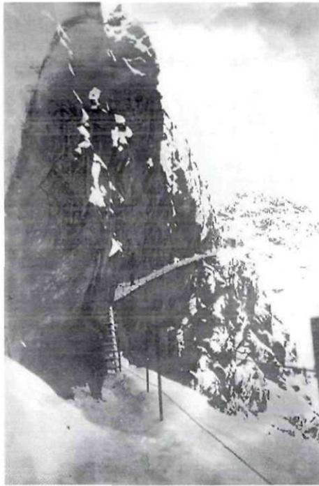
Abb. 3: Drahtseil-Hängebrücke an der Rivoletta, über die auch Gebirgsgeschütze transportiert werden konnten (Foto: Leo Handl)
