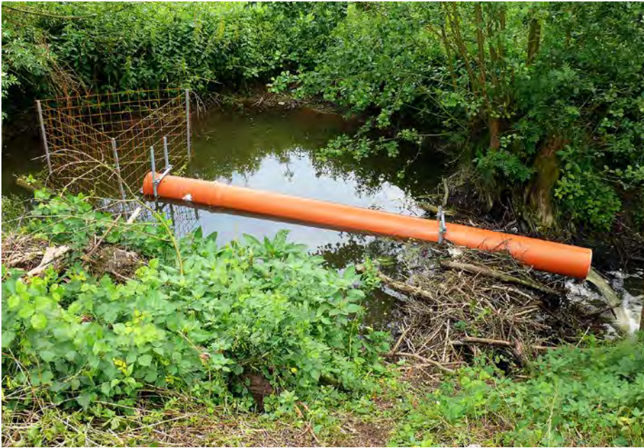
Abb. 3: Eine Dammdrainage senkt den Wasserspiegel auf ein für den Biber und den Landwirt akzeptables Niveau (Foto: Gerhard Schwab).
