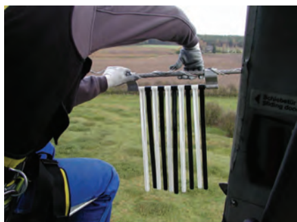
Anbringen eines Vogelmarkers am Erdseil aus dem Hubschrau- ber heraus (Foto: Archiv VSW)
