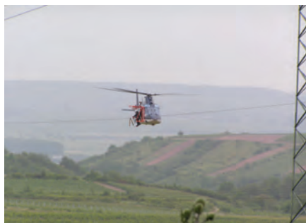
Nur bei gutem Wetter möglich: Hubschraubereinsatz zum An- bringen von Vogelmarkern (Foto: Archiv VSW)
