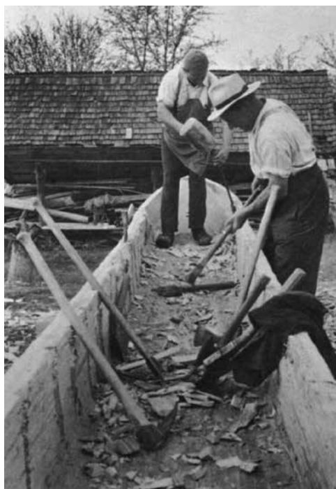
Ausarbeiten »Putzen« des »Prügl«.
