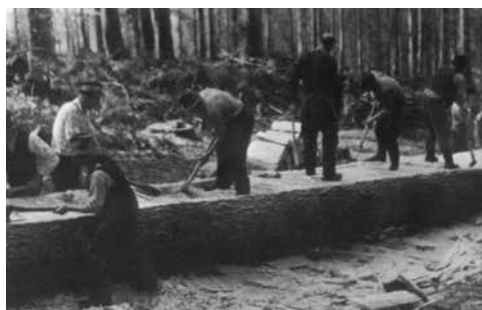
Einhacken in der Längsrichtung zum Entfernen des Überholzes.
