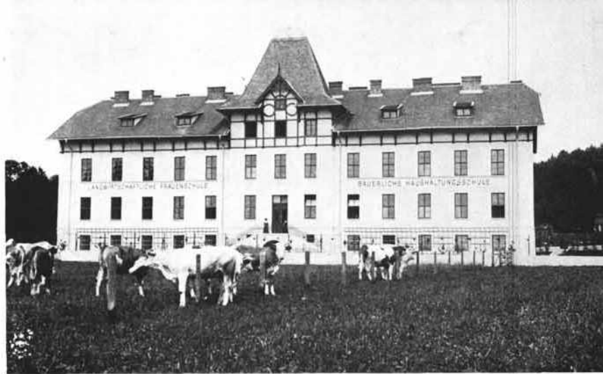
Abb. 2: Schultrakt des Gutes Otterbach bei Schärding zu Lebzeiten Wieningers.
