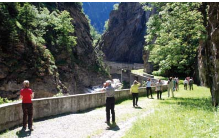
Abb. 51: Auf dem Weg in die »Gola del Monte Piottino«, durch die Urner Landvögte erst im 16. Jh. eine Straße bauen ließen. Finanziert wurde sie durch Zollgebühren. Heute führen Eisenbahn und Autobahn ins Tal und durch den Berg.
