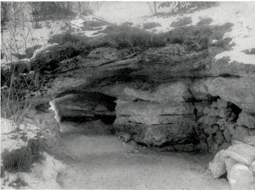
Fig. 2. Haupteingang („Eingang I“) der Höhle. Die aus den Bänken der Eggenburger Schichten bestehende Decke wird rechts durch eine künstliche Mauer abgestützt.
