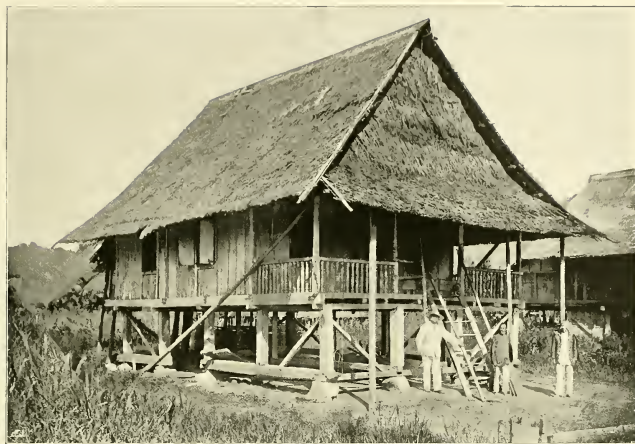
50. Haus in Kakas am See von Tondano.
