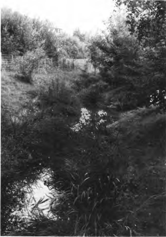
Abb. 24: Regenrückhaltebecken „Rumelner Bach“.
