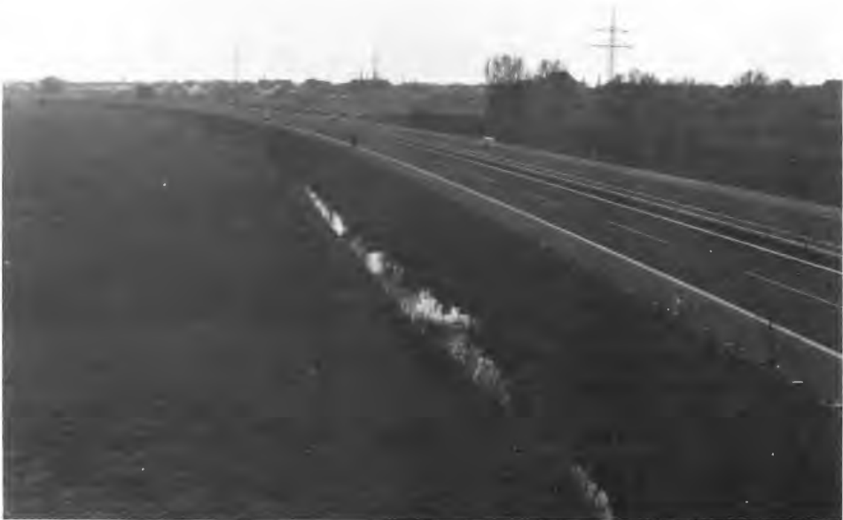
Abb. 40: Autobahnzubringer im Essenberger Bruch mit verlagertem Bruchgraben.
