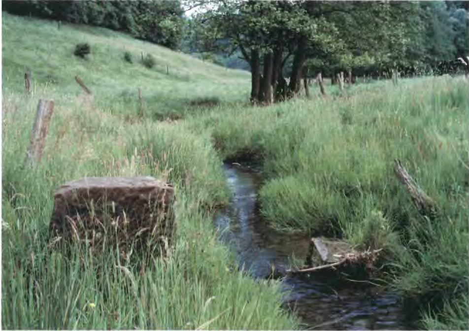
Abb. 27: Einfache Stauanlage an der Kobbeke bei Ertinghausen im Solling (Lkr. Northeim). Der Stein auf der rechten Seite ist bereits unterhöhlt worden und in den Bach gestürzt.
