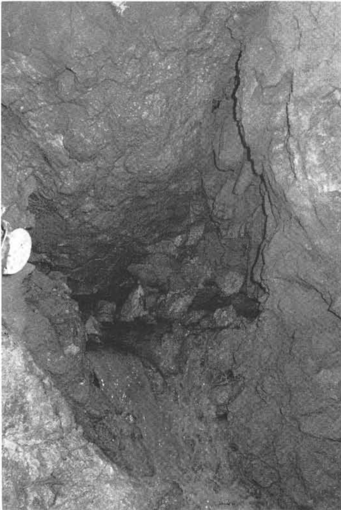
Abb. 34. Trümmerzone (Lehm und Blockwerk) mit Wasserzutritt. Südtrum, Station 665.
