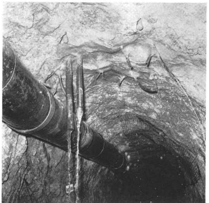
Abb. 47. Fassung von Wasserzutritten in der Firste nach dem Verfahren Oberhasli.
