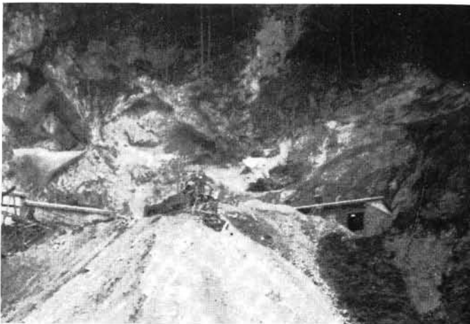
Abb. 5. Anschlagbereich Schneeealpenstollen-Nordtrum, bestehend aus wandbildendem Wettersteinkalk und -dolomit.
