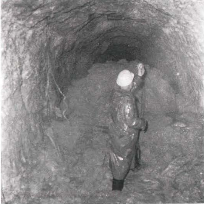
Abb. 20. Ende des Schlammstromes im Nordtrum bei Station 3320 nach dem Schlammeinbruch bei Station 4500.
