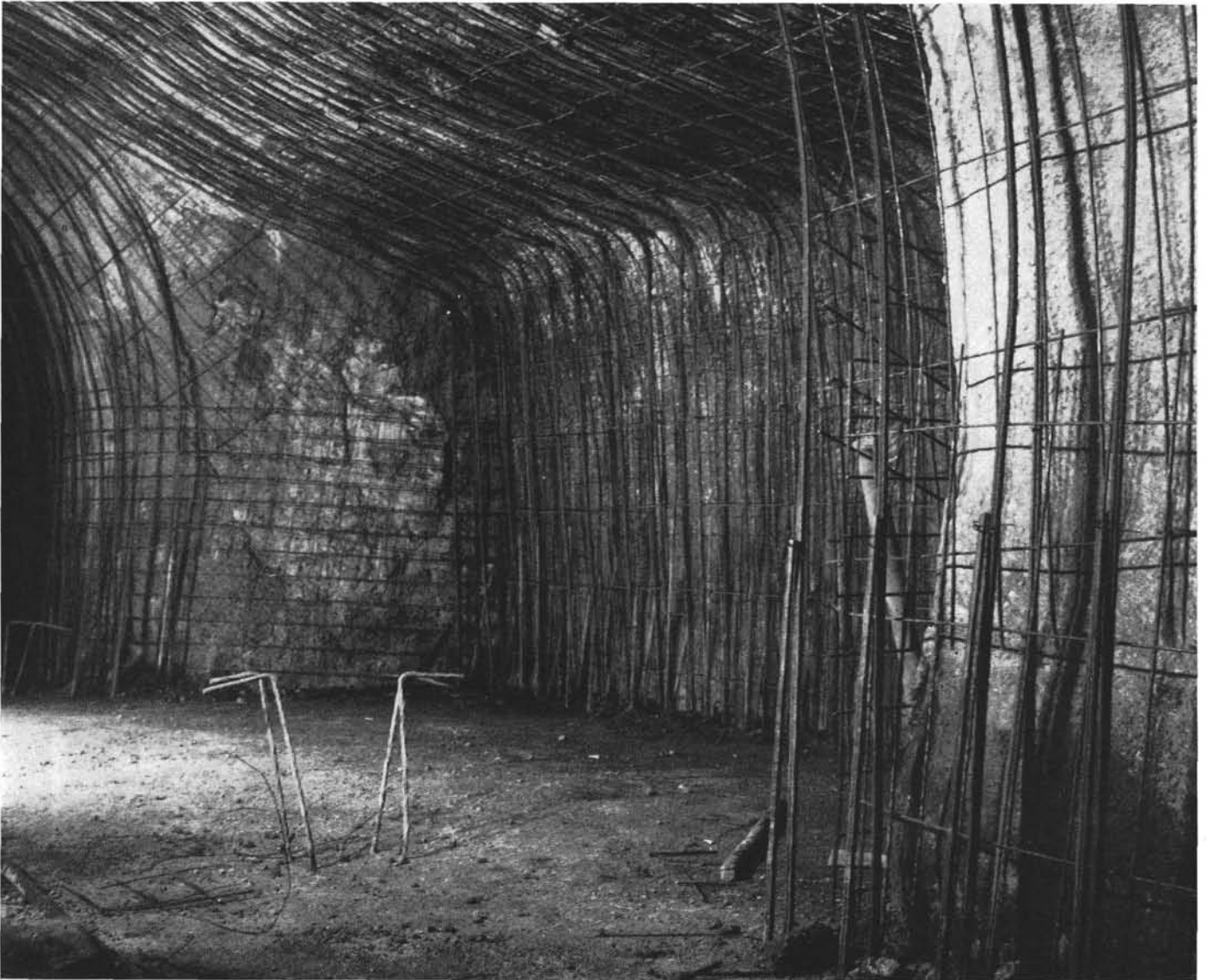
Abb. 45. Thorstahlbögen und -stangen zur Verstärkung der Baustahlgitterarmierung.
