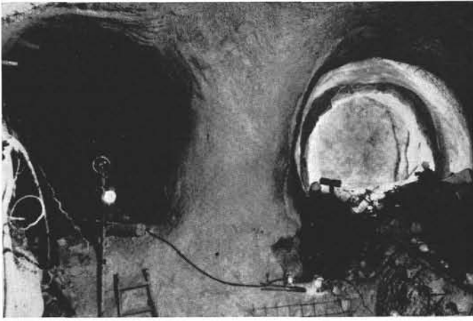
Abb. 32. Abzweigung des Umfahrungsstollens (Hauptstollens, rechts) vom aufgegebenen Blindstollen (Wasserhaltungsstollen, links). Südtrum, Station 488. Die geringe „Fleischstärke“ der Felszwischenwand zwischen beiden Hohlgängen bei gestörten Gebirgsverhältnissen an der Abzweigungsstelle machte eine Verstärkung durch schwer armierten Spritzbeton notwendig.
