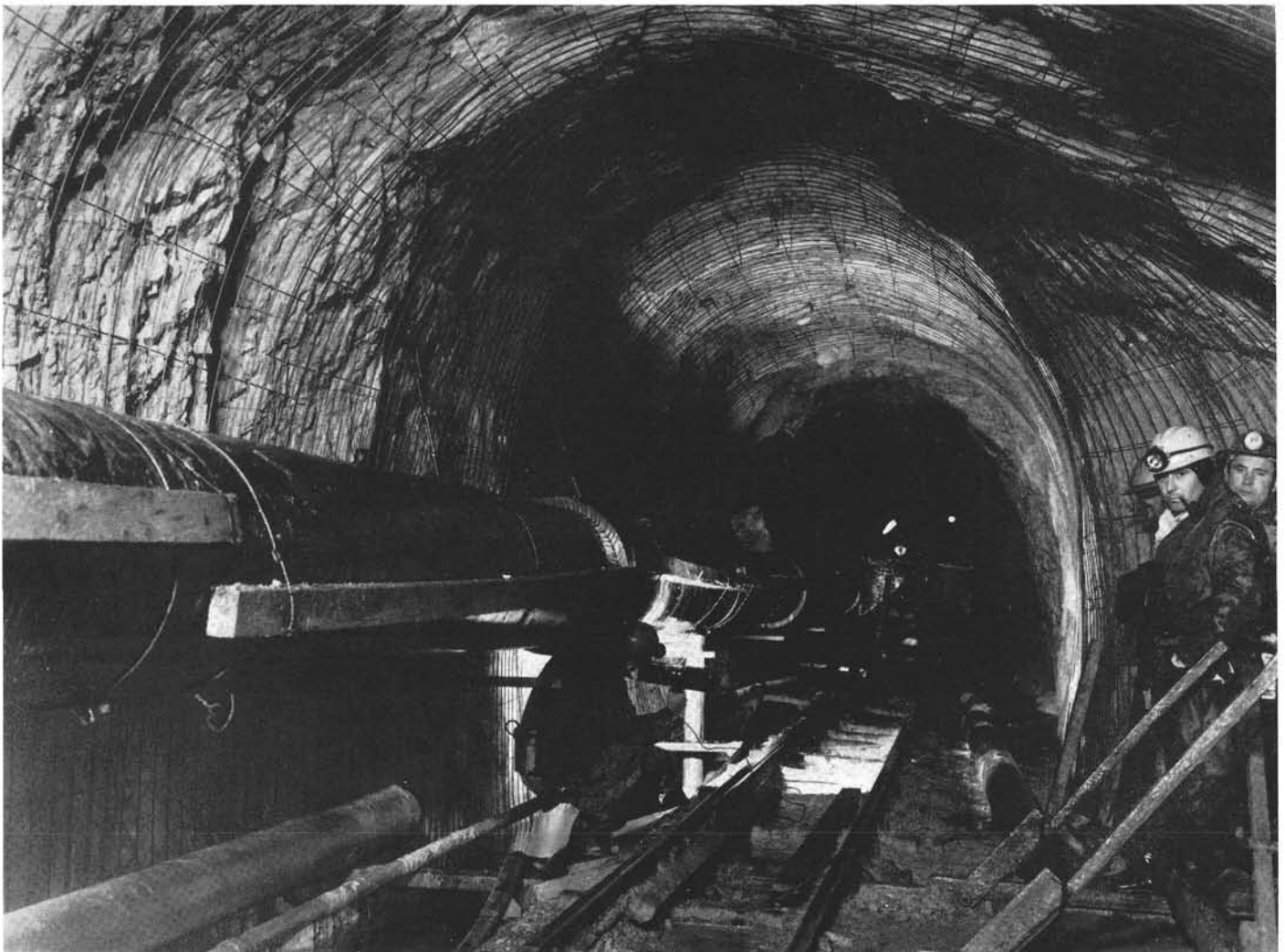
Abb. 44. Armierung mit Baustahlgitter.
