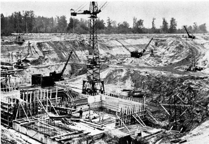
Abb. 2 Baugrube der Innstaustufe Rosenheim
