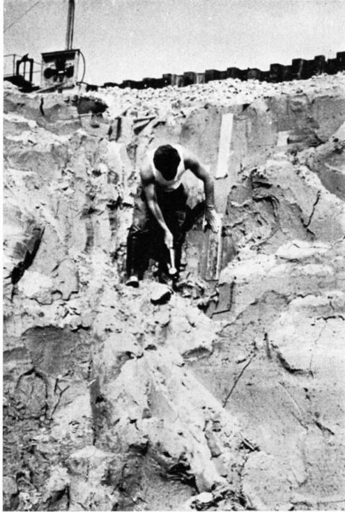
Abb. 1 Einbringen eines Entnahmekastens
