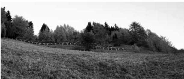
Fläche mit Handlungsbedarf, gesichert mit einer temporären Anrissverbauungen.
