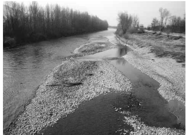
Aufweitung der Etsch bei Auer
