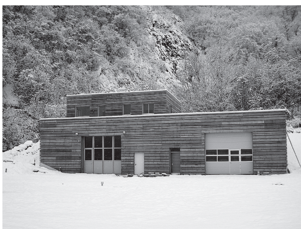
Neue Lagerhalle mit Sanitarräumen im Forstgarten Piglon – Pfatten gemeinsam mit der Gutsverwaltung Laimburg.
