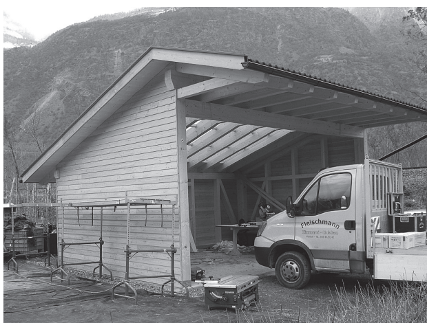
Neuer Vertopfungsraum im Forstgarten Kastelbell.
