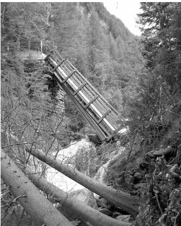
Auch zahlreiche Forst- und Almwege wurden vermurt und waren nicht mehr befahrbar (im Bild: Almweg Draßberg).
