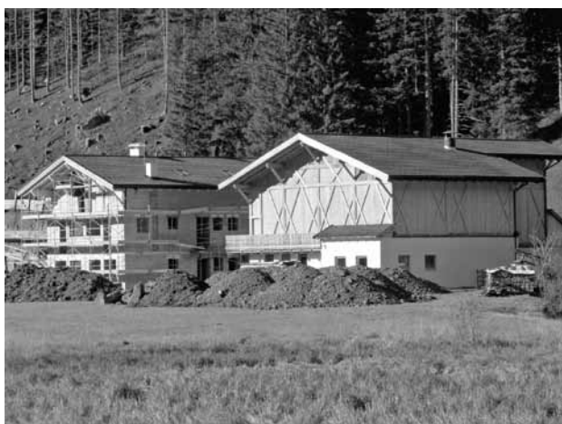
Neubau Wirtschaftsgebäude und Wohnhaus
