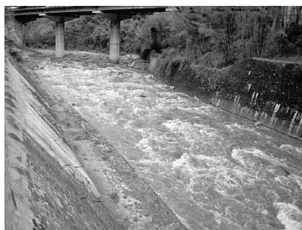
nachher: Rampe, welche die frühere Sperre ersetzt
