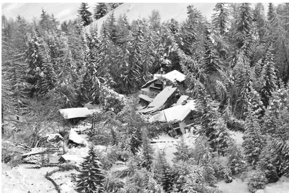
Mure in Abtei: Neben den großen materiellen Schäden an Gebäuden und Infrastrukturen wurden durch die Mure 32 Ha Wald und 10 Ha Landwirtschaftsflächen zerstört. In der Zwischenzeit sind rund 6.000 Vfm Schadholz auf der vermuten Fläche aufgearbeitet worden.
