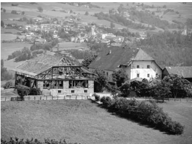
Wiederaufbau eines Wirtschaftsgebäudes
