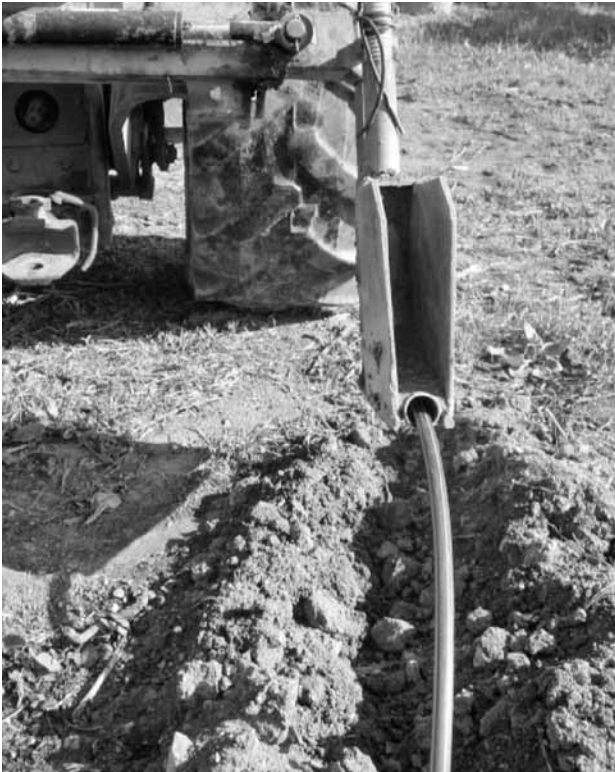
Abb.: Vorrichtung für die maschinelle unterirdische Verlegung des Tropfschlauchs
