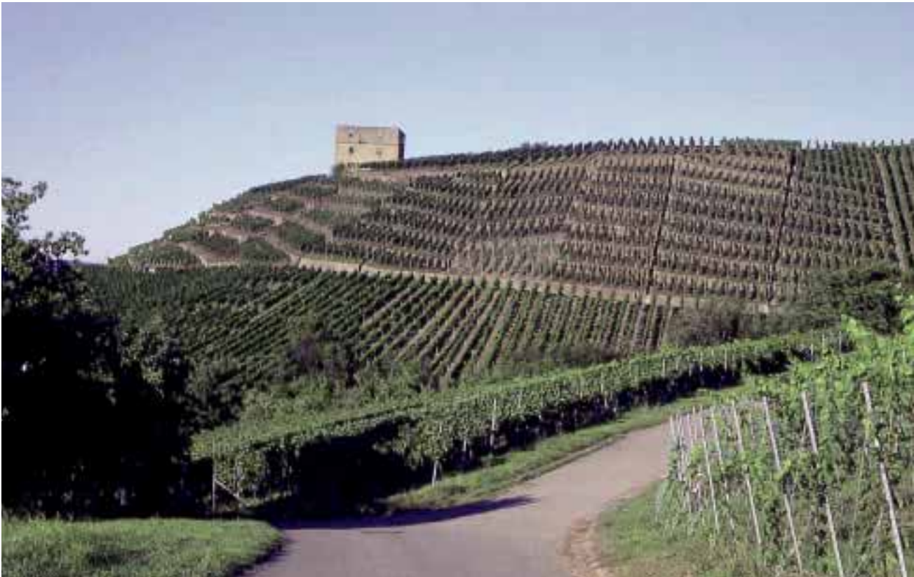
Abbildung 6: Der Pulvermächer-Weinberg bei Kernen-Stetten im Remstal. Die kühne, fischgrätartige Konstruktion der Mauerzüge ist eine kulturtechnische Meisterleistung (Photo: F. Höchtl)
