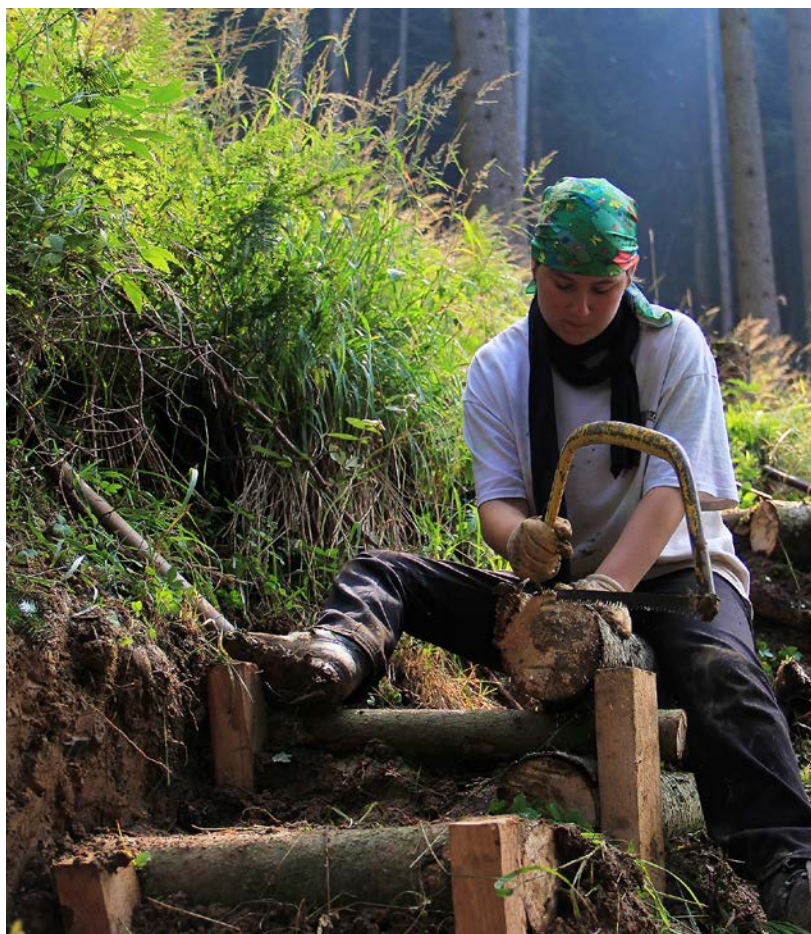
Abb. 2: Damit die gepflanzten Bäume gut aufwachsen, ist eine engagierte Bejagung erforderlich. Zusammen mit den Jagdpächtern wurden daher auch Steige angelegt, wodurch zudem das Programm vielseitiger wurde.
