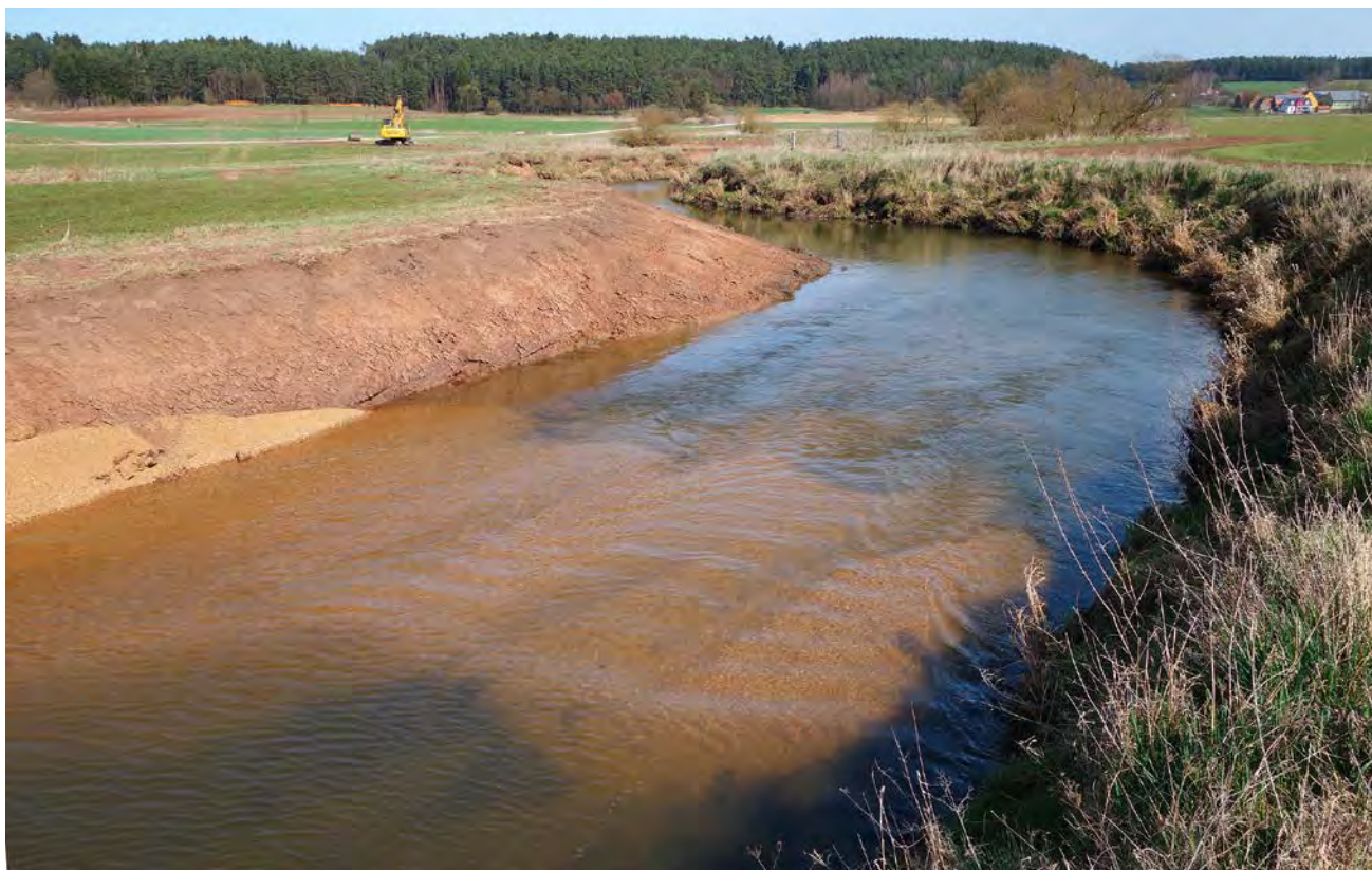
Abb. 12: Blick auf eine Kies-Einbringstelle bei Bechhofen kurz nach der Maßnahme – eine langsamere Fließgeschwindigkeit ist schon erkennbar.
