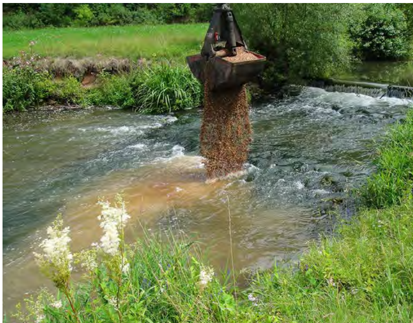
Abb. 6: Einkippen von Kies unterhalb eines Sohlabsturzes in die Schwäbische Rezat mit Hilfe eines Baggers.
