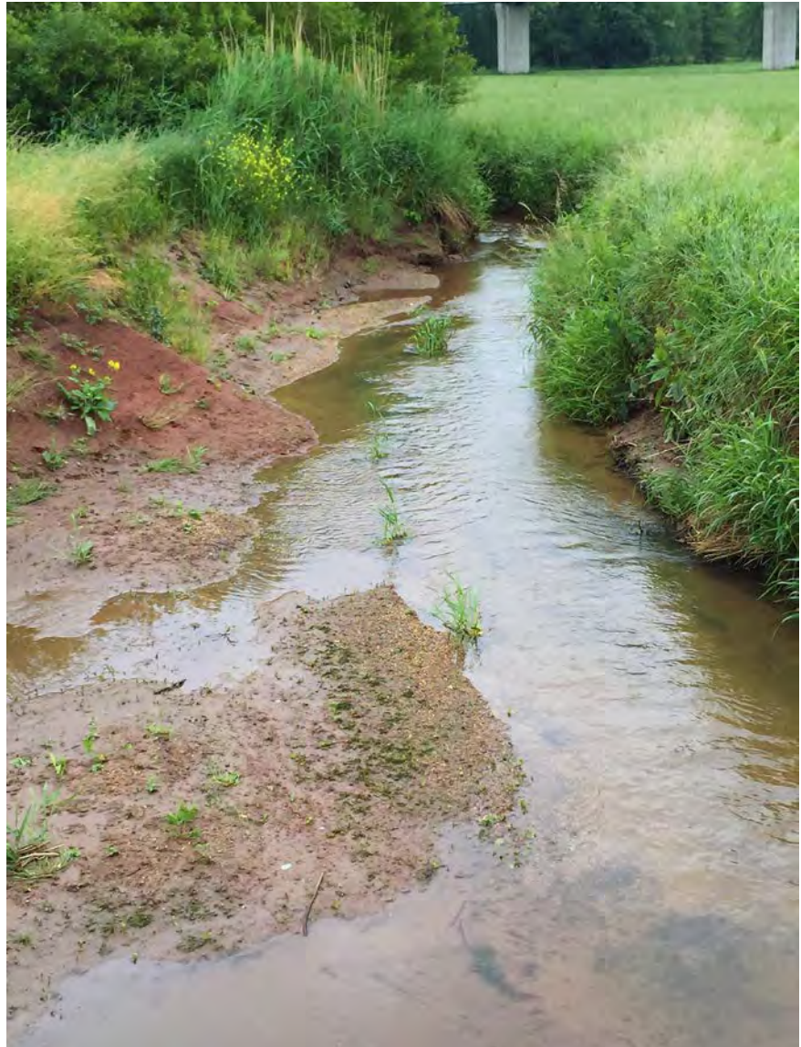
Abb. 14: An der Zenn konnte die Sohle flächig belegt werden, was zur gewünschten Dynamik, wechselndem Stromstrich und erhöhten Turbulenzen geführt hat. Hohe Strukturvielfalt am Ufer und auf der Sohle; Sortierprozesse führen zu Strömungsvielfalt.
