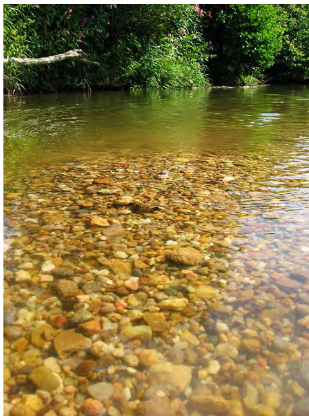
Abb. 10: In die Fränkische Rezat eingebrachter grober Kies von 30 bis 60 mm, der dort wegen zu geringer Fließgeschwindigkeit am Boden liegen bleibt.
