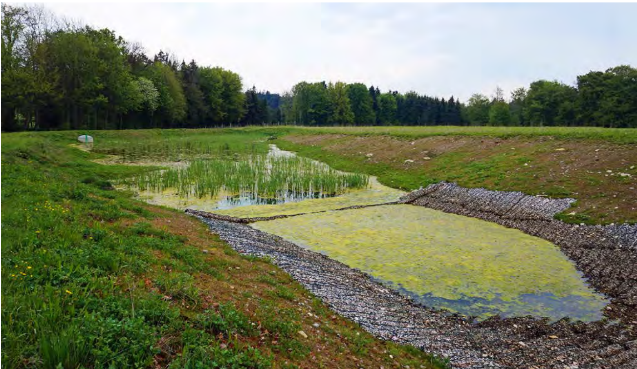
Abb. 5: Das 2015 fertiggestellte Sickerbecken bei Ebing im Einzugsgebiet des Waginger Sees dient dem Rückhalt von Phosphor aus Dränwasser durch Hangversickerung (Foto: Hannes Krauss).
