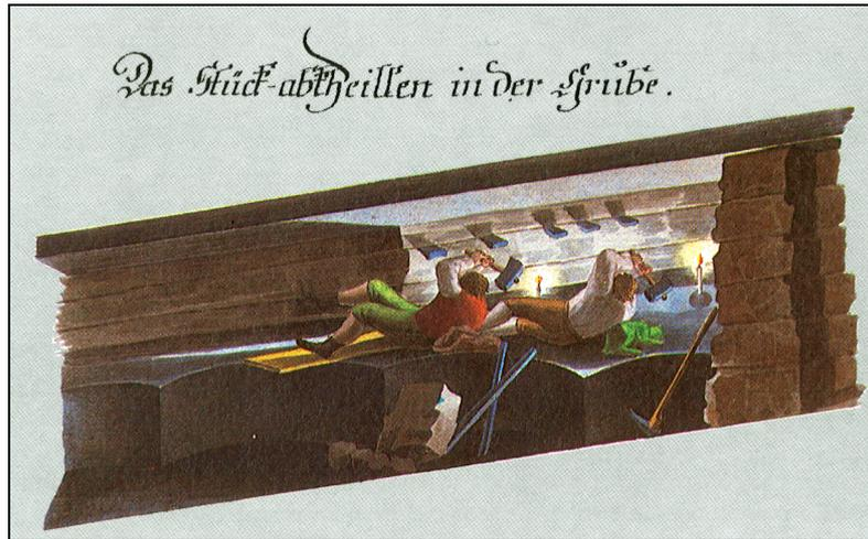
Abb. 6: Historische Darstellung der Mülsteingewinnung im Untertagebau (aus ENGLEITNER, 1806).
