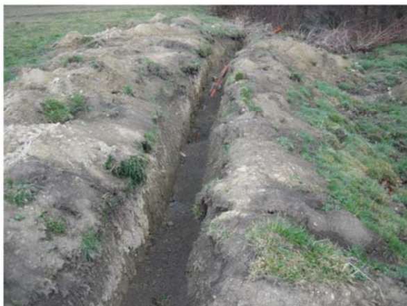
Sanierung des Baches durch Rohrleitung.
