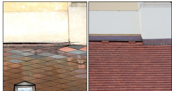
Vor und nach der Dachneudeckung
