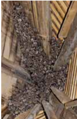
Am Morgen ist es im Giebelbereich am wärmsten (Große Mausohren in der Kirche von Neumarkt im Tauchental)
