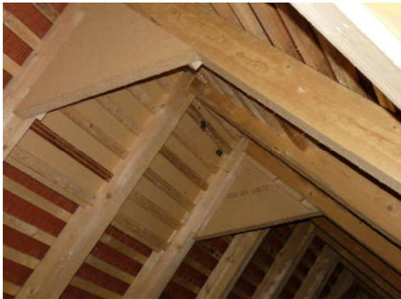
Wärmeglocken werden an der Dachhaut im Firstbereich angebracht. Dreieckige Bretter an beiden Seiten schließen den Raum, in dem sich die warme Luft fängt, ab. Bei kalter Außentemperatur wird durch eine thermostatisierte Heizung eine für die Kolonie optimale Temperatur erzeugt, Es handelt sich um eine ausgefeilte, international erprobte Technik mit Erfolgsgarantie.
