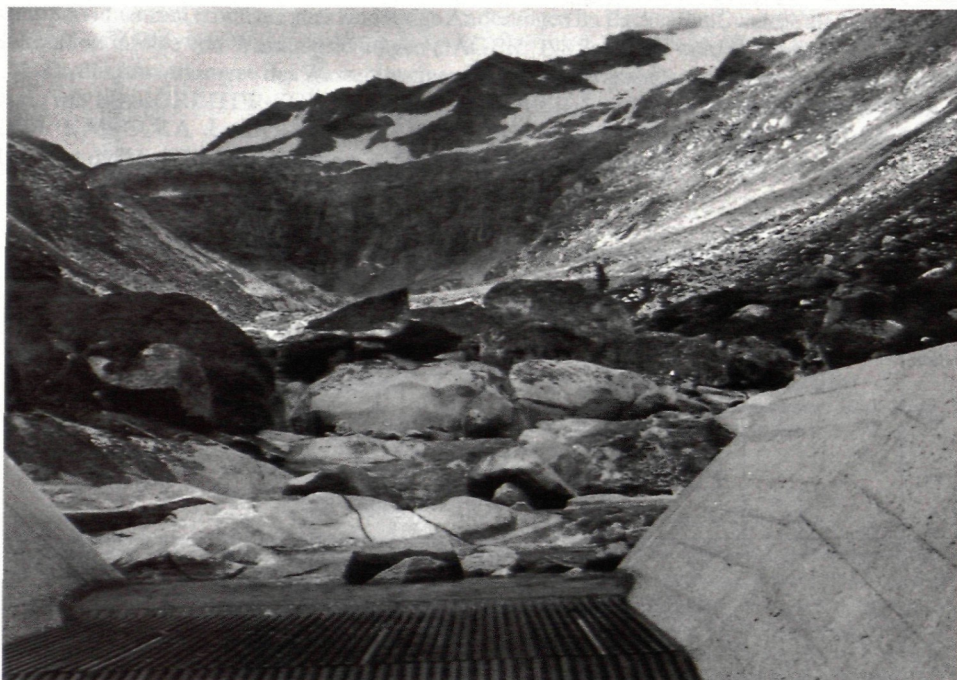
Foto 2: Untere Landeckbachfassung, 1981 m.
