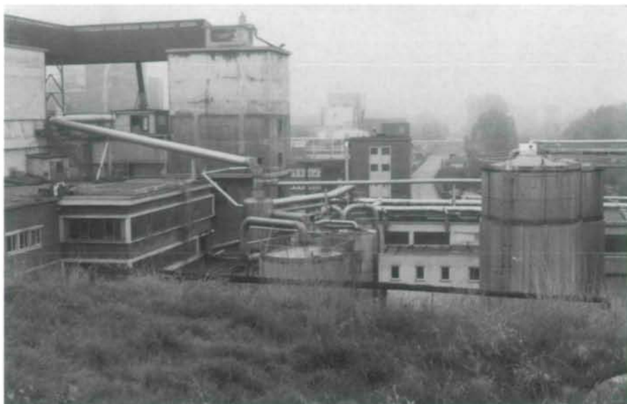
Abb. 23: Westrand des Plateaus mit der Agrostis capillaris -Brache. Am Rand zum Anriß der Straße der verkohlte Holzzaun. Blick auf die Köcherei, rechts ein Stapelturm, etwa in der Mitte ein Blastank, links dahinter einer der Kocher. Oktober 1994.
