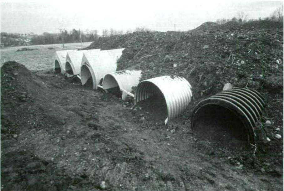
**Abb. 1:** Die Anlage im Bauzustand – Betonrohre, ein Hobas-Rohr (Hobas ist die Bezeichnung der Herstellerfirma), ein Stahlblechrohr und ein Pecor-Rohr (Pecor ist die Bezeichnung der Herstellerfirma) wurden in den Vergleich miteinbezogen.
