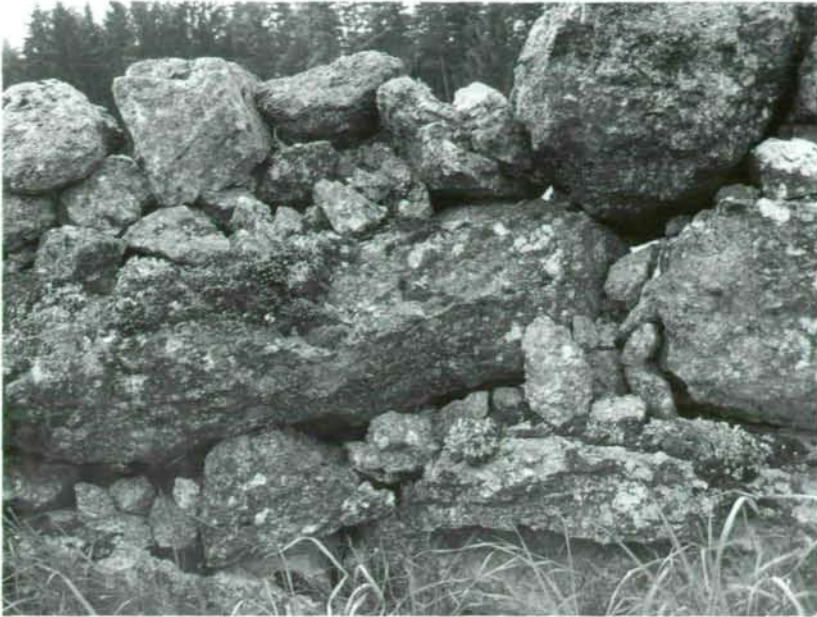
Foto 11: Lesesteinmauer Plochwald (760 m, 7554): Lesesteine werden im Mühlviertel auch "Klaubsteine" genannt: Unterschiedlich große Steine werden in Äckern aufgeklaut (aufgelesen), am Feldrain ohne große Sorgfalt abgelegt und grob geschichtet. So entsteht aus einer einfachen Lesesteinzeile oder aus aneinandergereihten Steinhäufen mit der Zeit eine nicht sehr stabile Lesesteinmauer.
