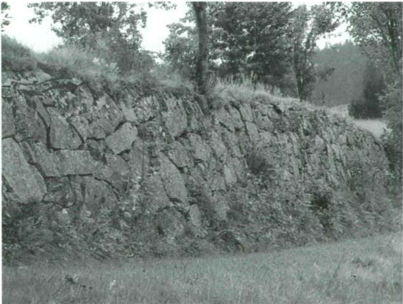
Foto 8: Feldmauer Prendter Höhe (760 m, 7453): Diese ungewöhnlich hohe Mauer ist aus Stabilitätsgründen schräg geneigt und besonders sorgsam geschichtet.
