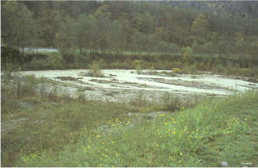
Abb. 3: Das Ausschotterungsbecken am Fritzbach bei Hochwasser: deutlich ist das Ausfluten des Baches am orographisch rechten Ufer erkennbar, das zu ausgedehnten Schwemmflächen führt.
