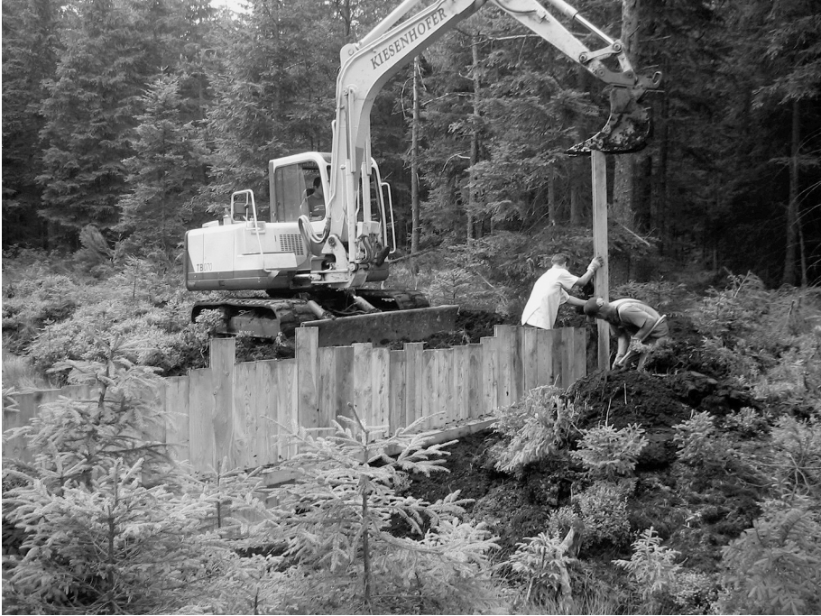
Abb. 32: Bau einer Grabensperre in den Roten Auen (Foto I. ORTNER).
