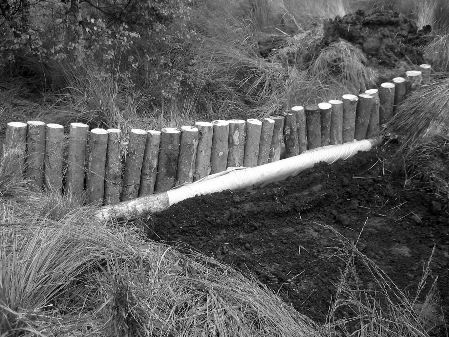
Abb. 38: Grabenanstau mit Rundholzsperr und Torfhinterfüllung in der Nördlichen Bumau (Foto H. HAUBNER).
