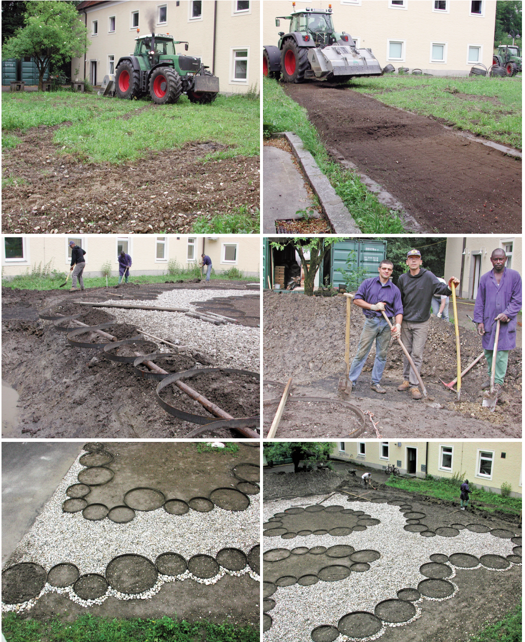
Abb. 14-19: Anlage des Sonderausstellungsbereiches im Bereich zwischen Hauptgebäude und Werkstattgebäude. Fotos: Archiv Biologiezentrum.
