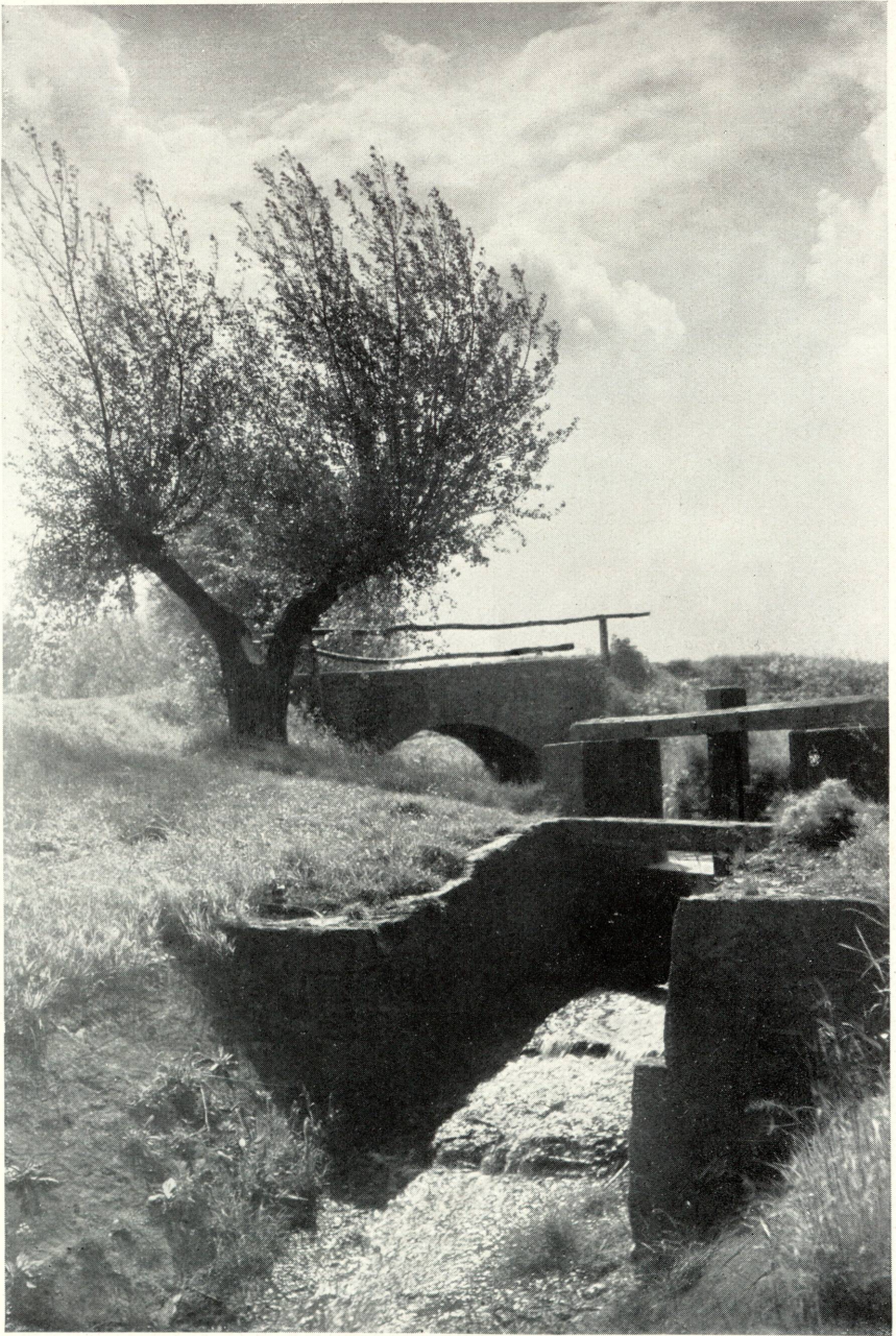
Künstlerisch vollkommene bäuerliche Schleusenbauten aus Naturstein und Holz. Phot. Landesv. Sächs. Heimatschutz.
