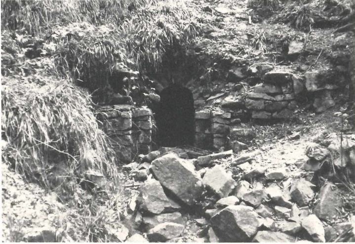
Abb. 14. Altes Mundloch im Bereich der Grube Christian im Schnaizteich/Neuenbürg. Breite des Mundlochs 60 cm. Fotografiert im Mai 1979.
