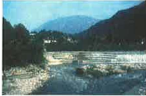
Triftwehr in Bad Reichenhall
