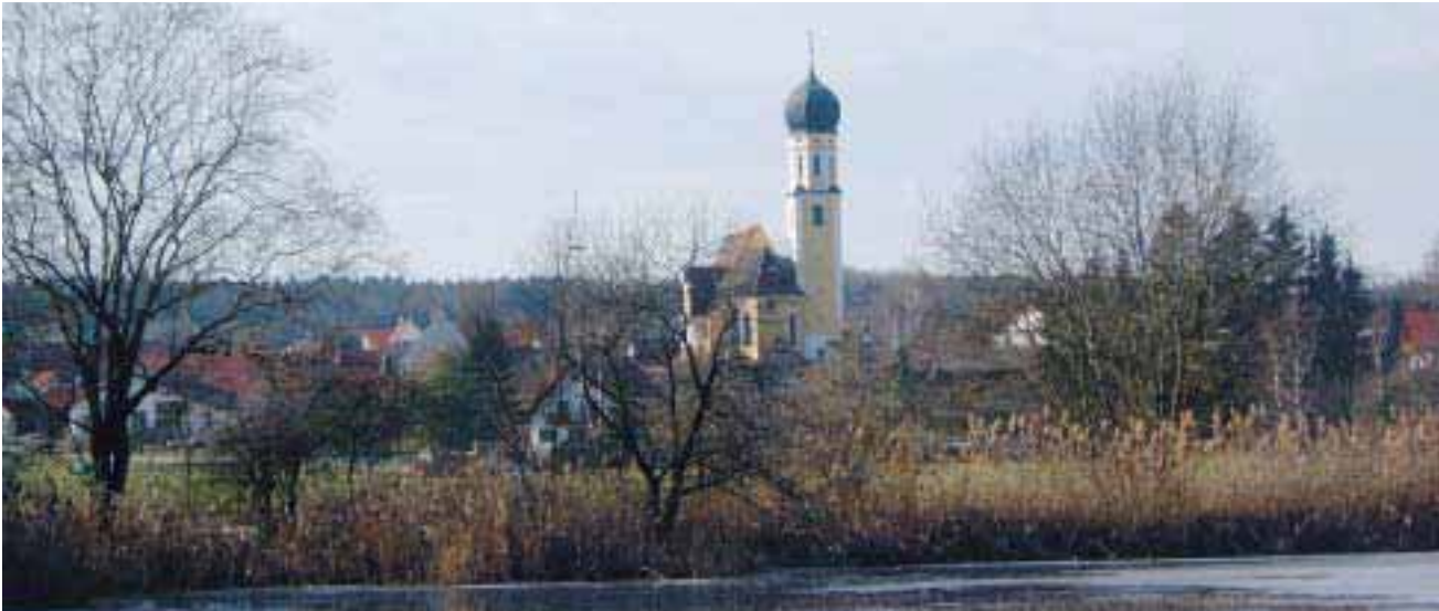
Abbildung 14: Eresing – Ort des Lebens. (Ansicht von Südosten)
