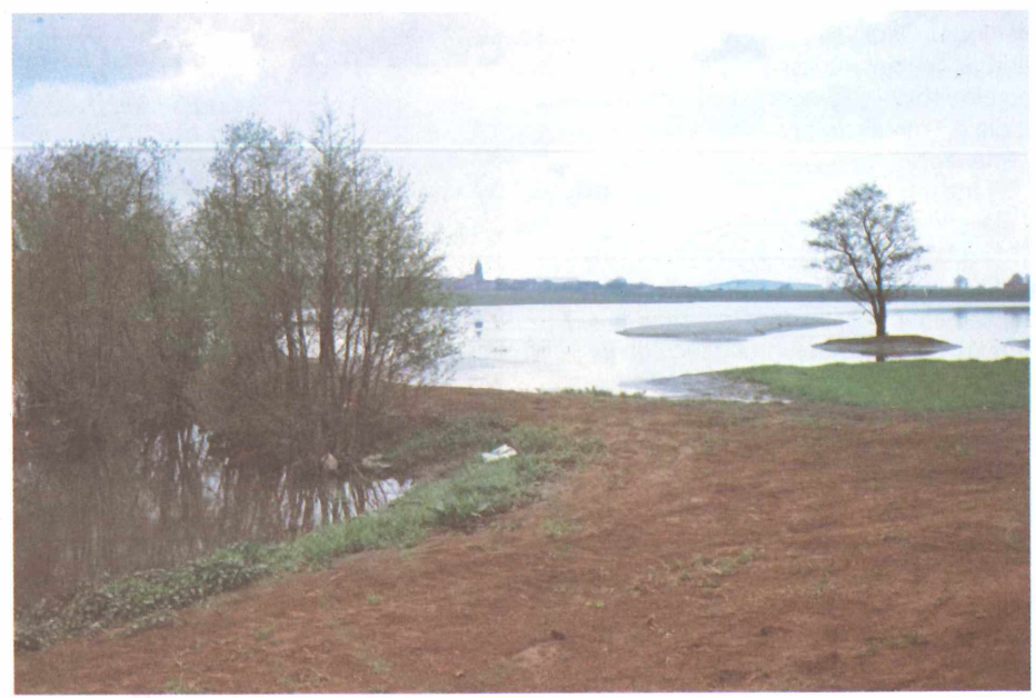
Neugeschaffene Hochwasser- rückhaltung (28 ha, davon 8.5 ha Grundsee): Flachwasserzonen, Inseln mit Kiesschüttung, Gumpen und Pflanzungen stärken das Ökosystem.
