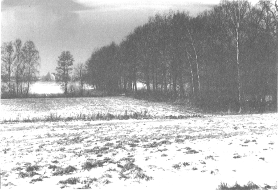
Abb. 4 Teichdamm des ehemaligen Neitschteiches
