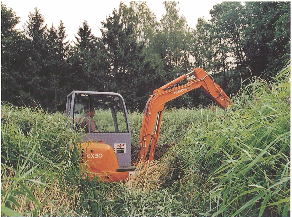
Beginn der Baggerarbeiten am 1. August 2001
