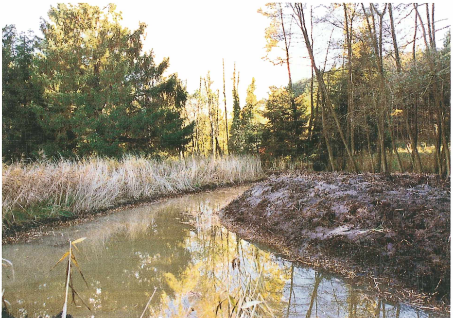
Erweiterung des Teiches – der Aushub als Böschung
