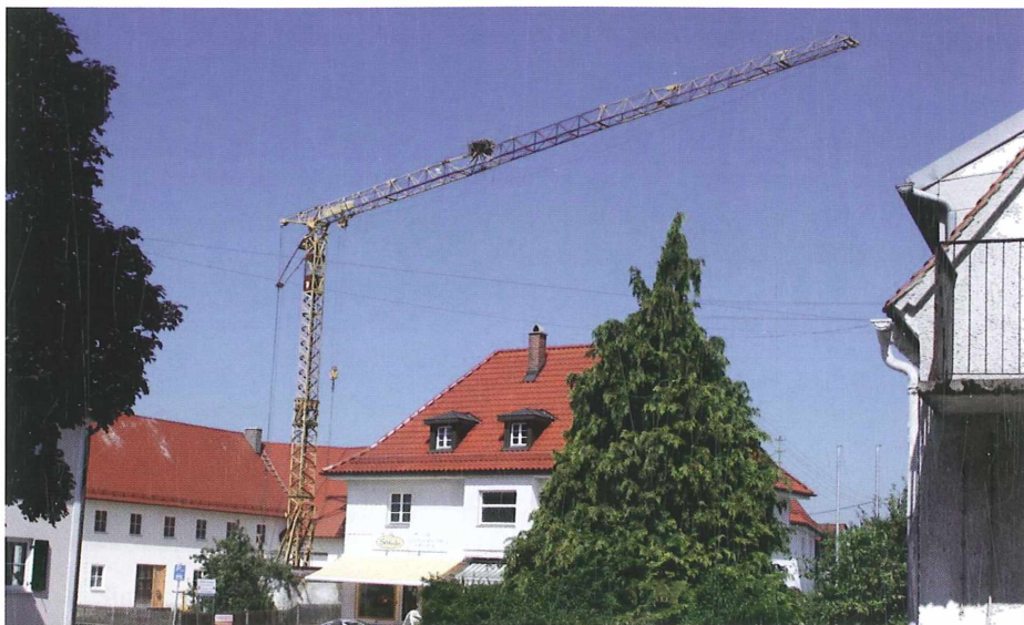
Abb. 1: Kein Brutplatz auf Dauer. Baukran im Hof eines Gessertshausener Landwirts.
