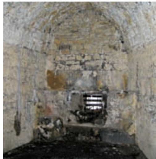
Teil der Kasematten im Windmühlenrondell
